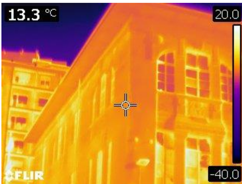
Figura 2.2 – Immagine termografica facciata
